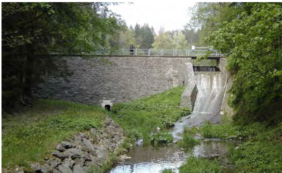
Obrázek 5 Současný stav hráze
