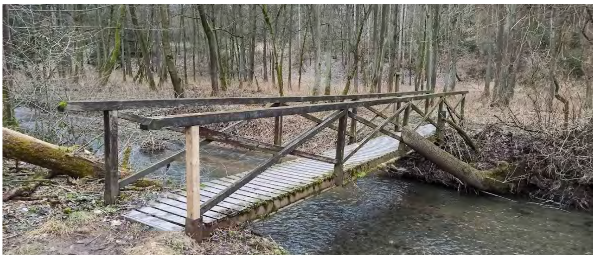
Obrázek 7 Současný stav lávky
